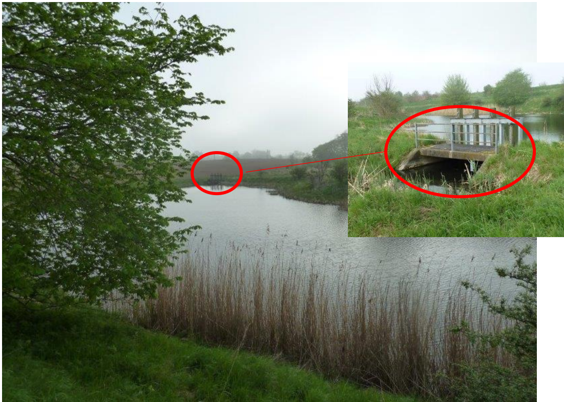
Figur 17 visar norra delen av dagvattendammarna och befintligt utlopp som består av ett öppet bräddavlopp och vegetationsfyllt dike ut i ån.
