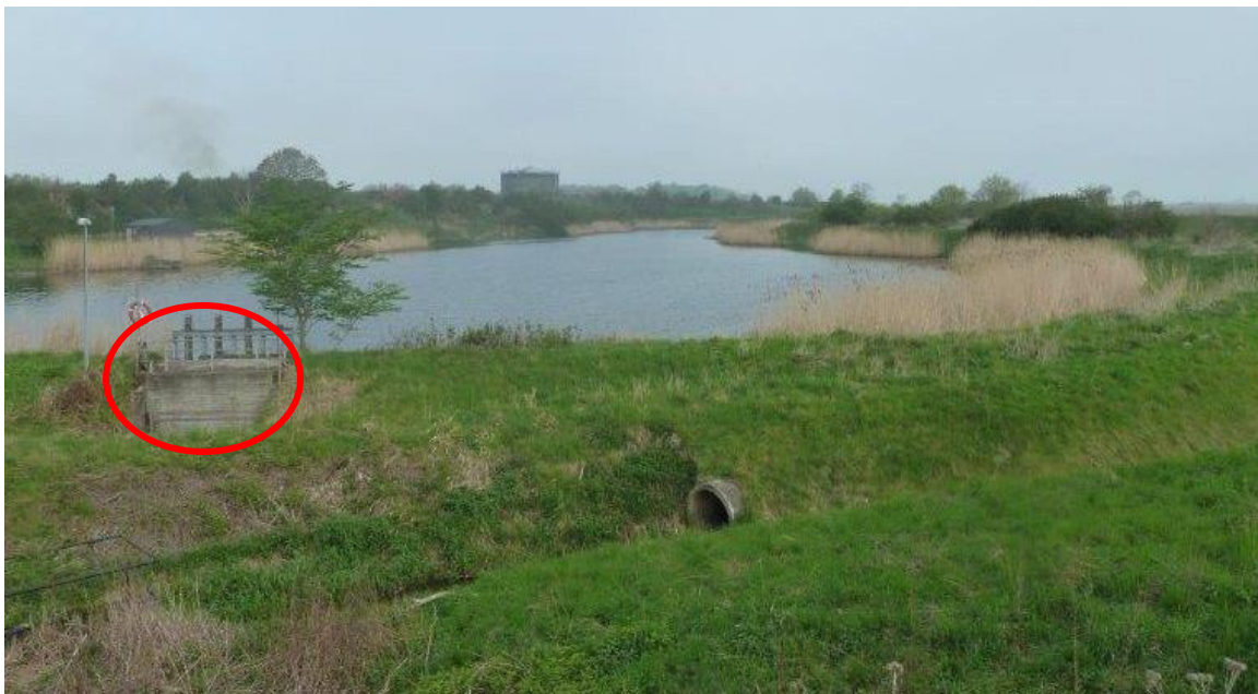
Figur 18 visar befintligt betongdämme i södra delen av dagvattendammarna.
