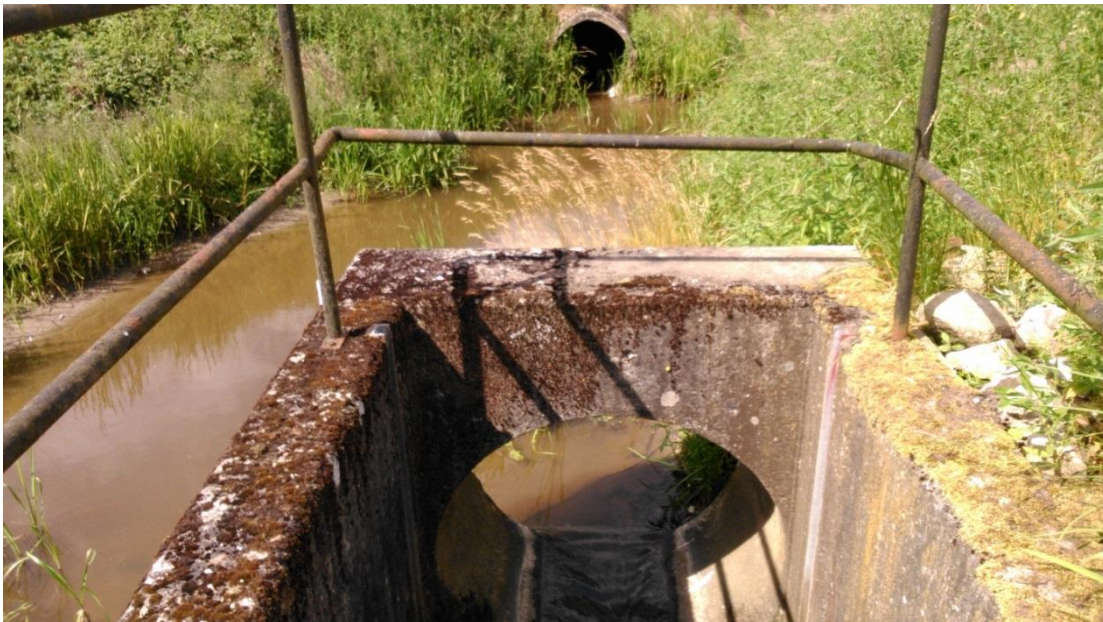
Figur 25 visar befintlig kulvertöppning omedelbart nedströms dagvattendammarna
