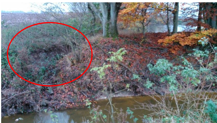
Figur 30 Befintligt in- och utlopp i kritbruksdammen består av ett öppet dike från den norra delen av dammen ut i ån.
