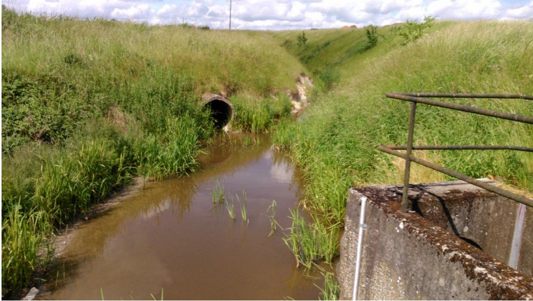
Figur 7 visar åfära och kulvertöppning nedströms dagvattendammarna vid lågflöde
