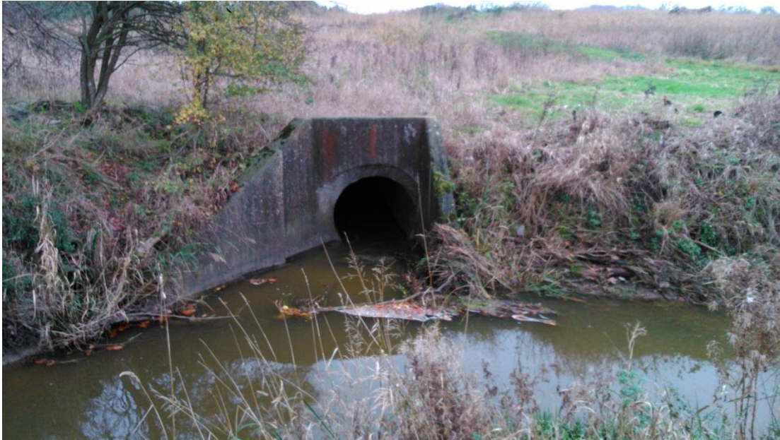
Figur 24 visar befintlig kulvertöppning i den norra änden av kulverten.
