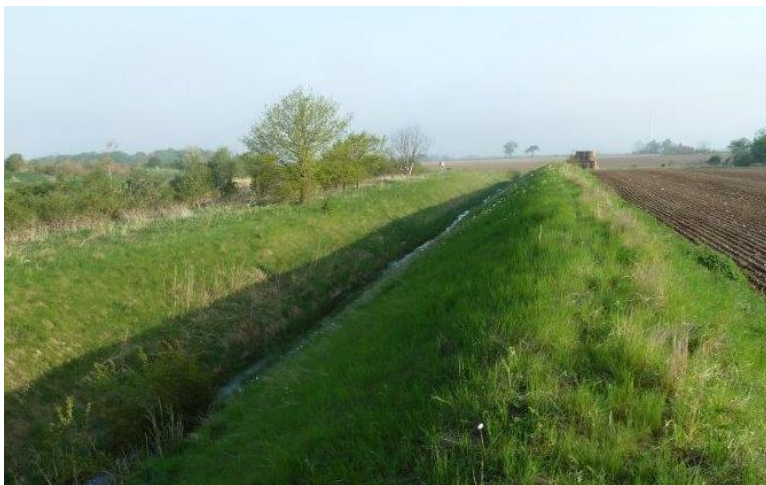
Figur 26 Bild från den öppna fåran vid dagvattendammarna.
